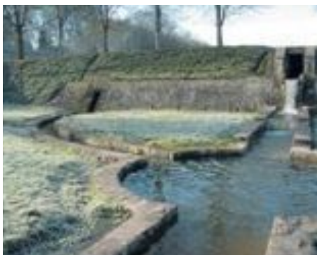
Ci-dessus, le deversoir à l'extrémité du grand canal.
